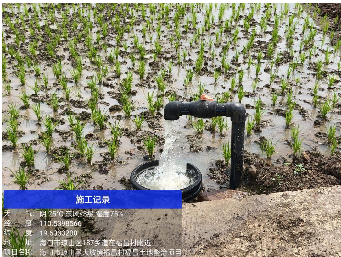
图 7 竣工后放水口
