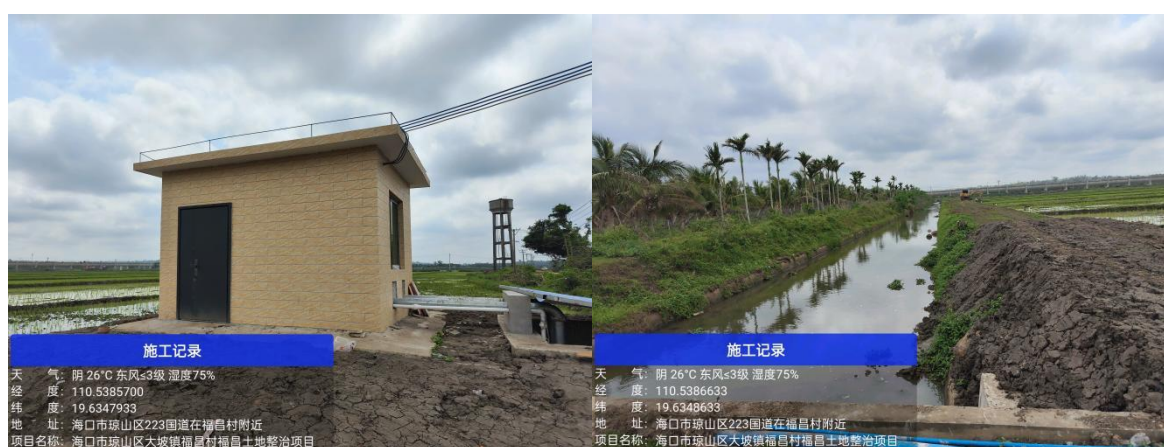
图 14 泵房及水源照片
