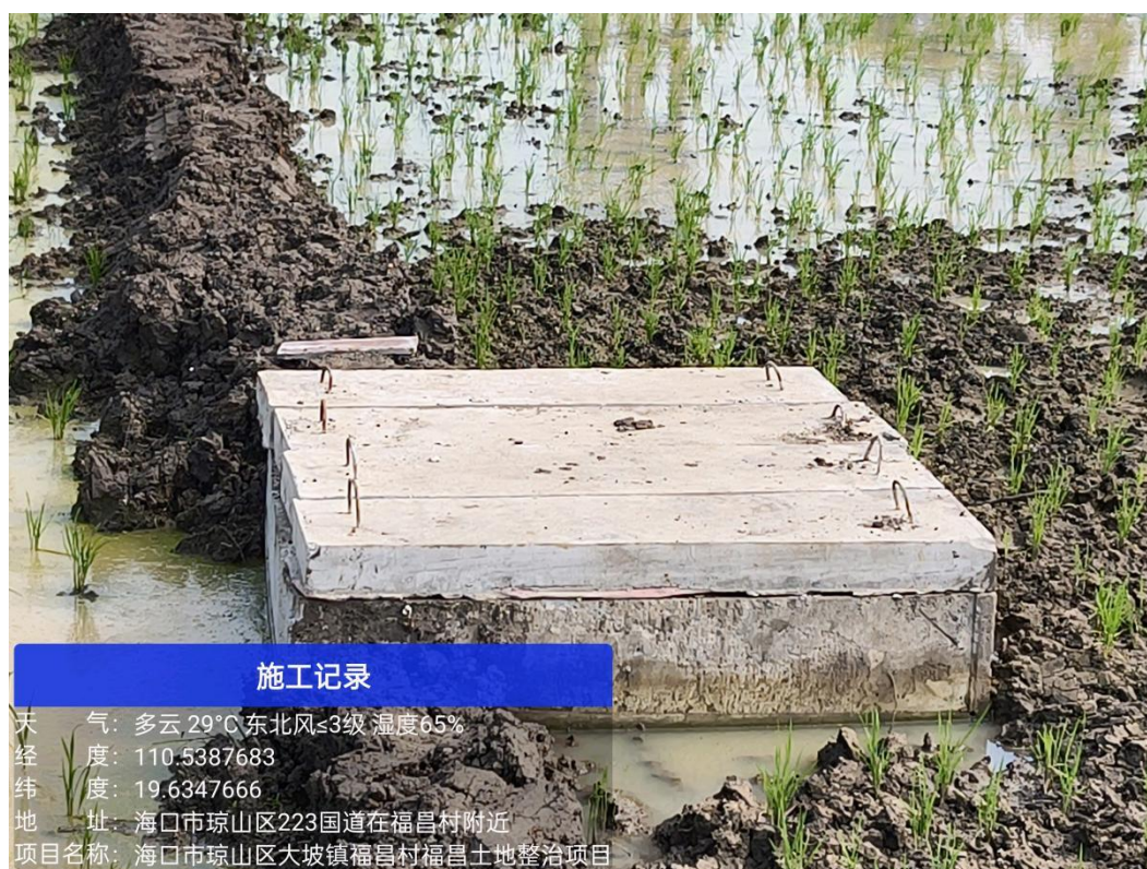
图 9 竣工后检修井
