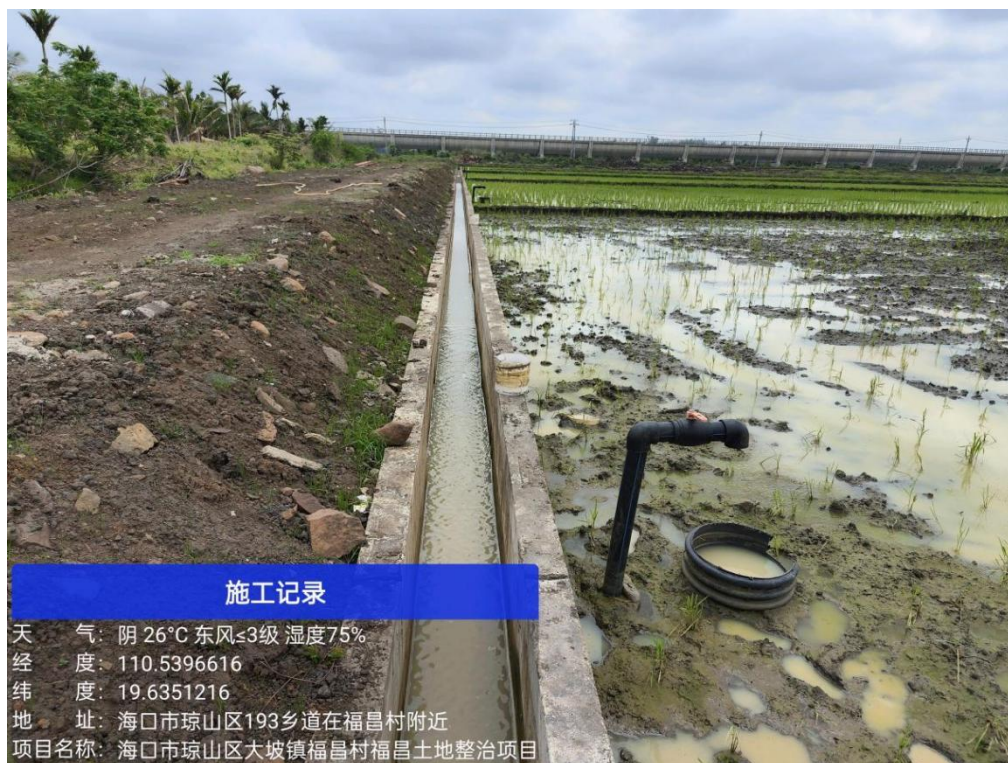
图 5 竣工后排水沟
