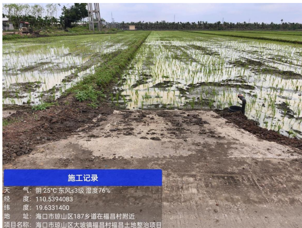
图 6 竣工后下田坡道
