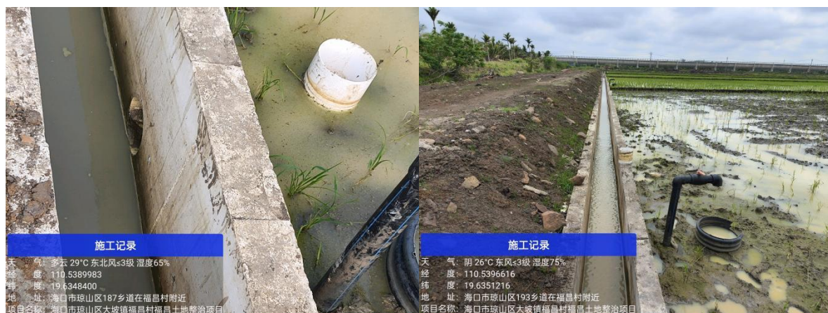
图 15 竣工后排水口和排水沟照片
