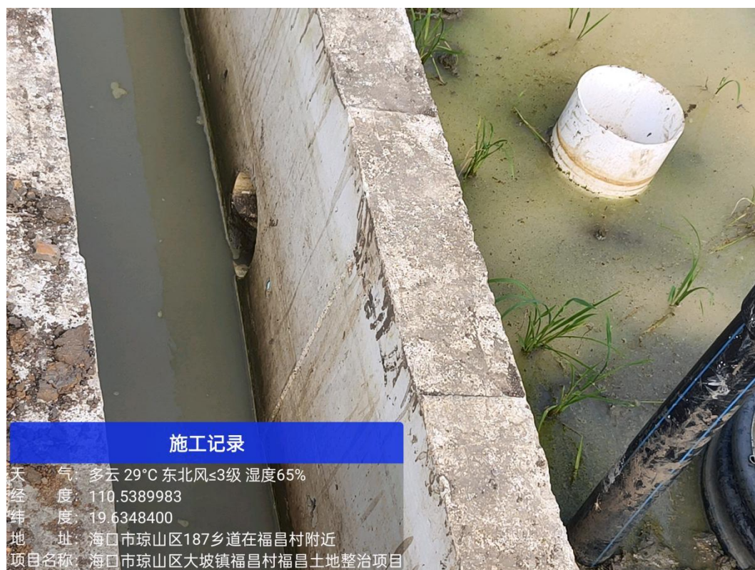
图 8 竣工后排水口
